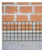
Junção da lage com a alvenaria de platibanda
